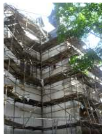
oprava jižní stěny kostela
